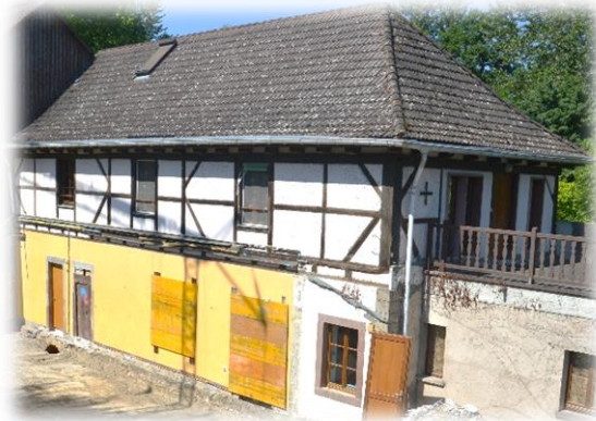
et démolition de la Verrière
