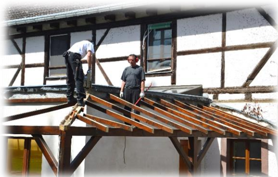
Démontage du toit de la coursive
