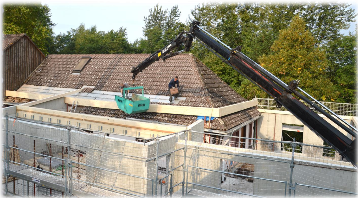
Les murs s'élèvent, la charpente est posée
